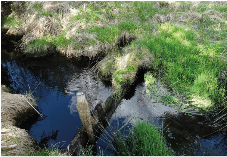
Abb. 13: Umspülter Holzstau im Hauptgraben. April 2016. Foto: A. Ebhart.
